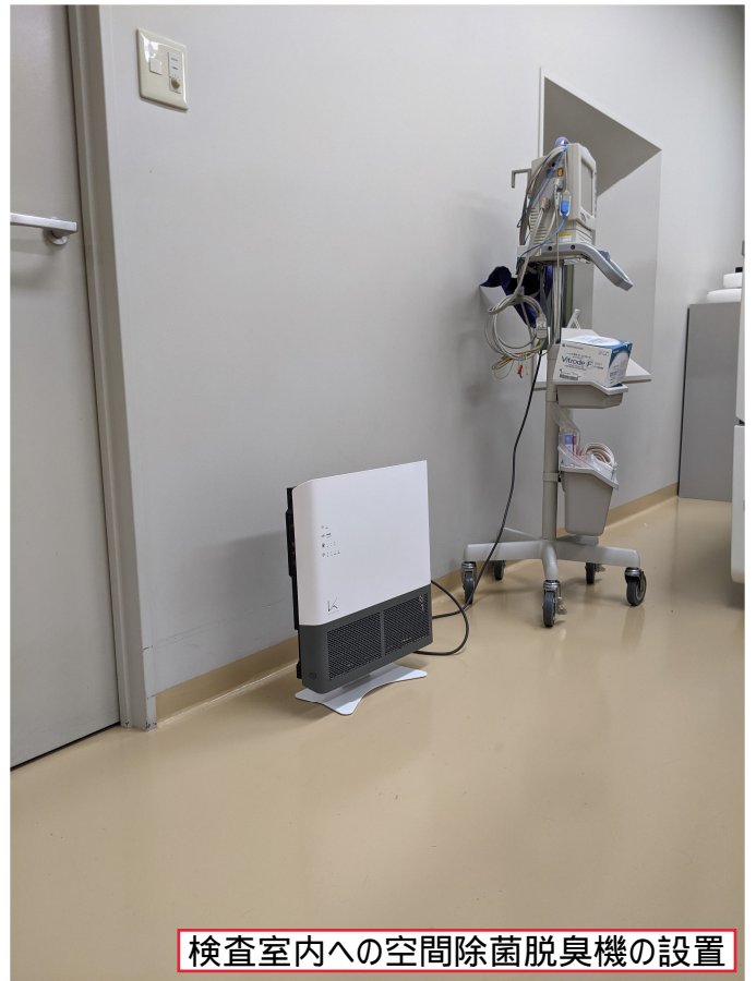
更衣室への空間除菌脱臭機の設置
